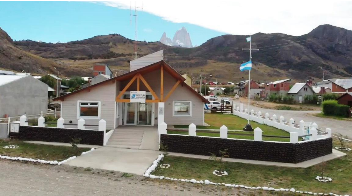
Figura 19. Nueva sede de Prefectura Naval Argentina en El Chaltén.
