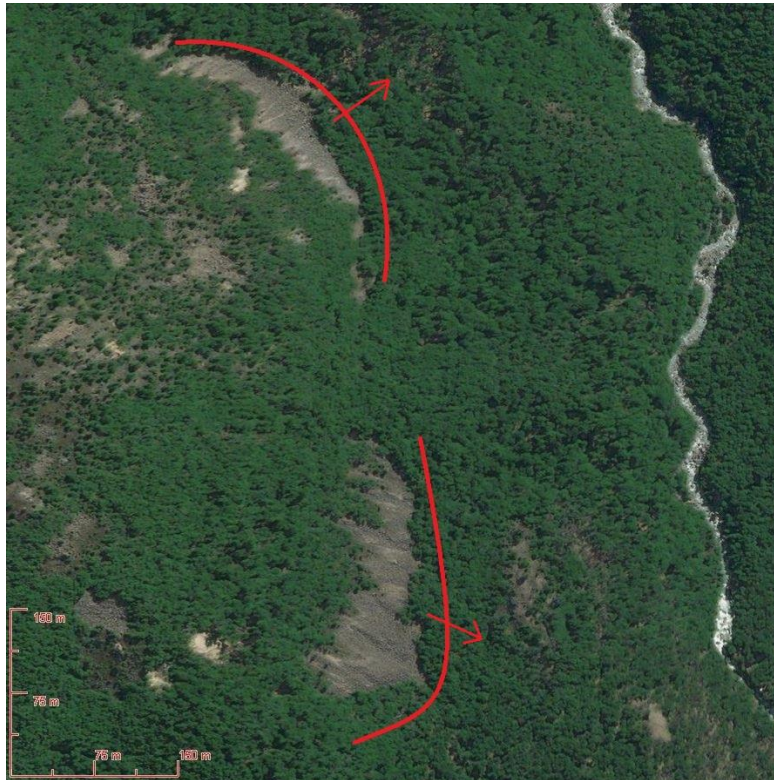
Figura 26: Grietas o fallas de deslizamiento (líneas rojas)
