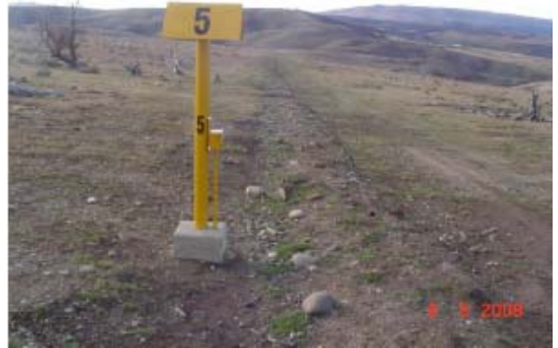
Figura 70. Señalización del gasoducto
