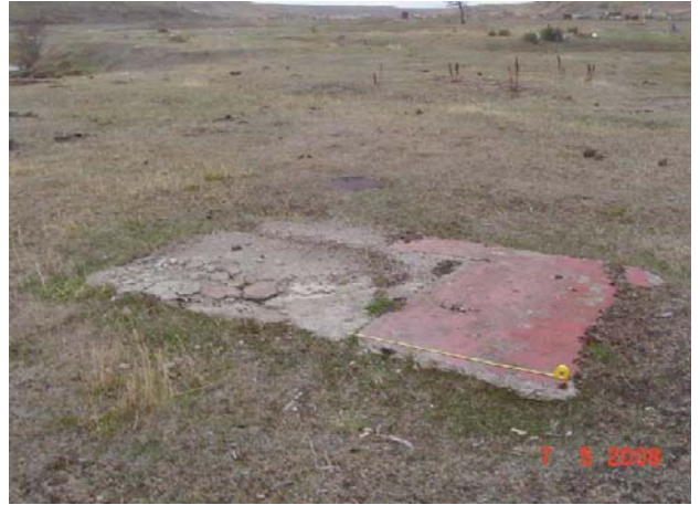
Figura 58. Contrapiso de las dependencias del ferrocarril
