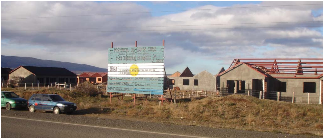
Figura 29. Plan de vivienda en ejecución
