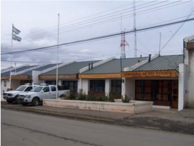
Figura 42. Comisaría y destacamento de Bomberos de Río Turbio
