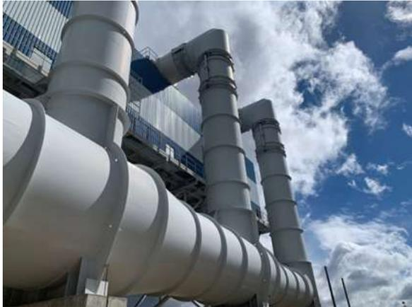
Imagen N° 83. Tuberías del circuito agua – vapor / “calles”
