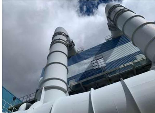
Imagen N° 84. Tuberías del circuito agua – vapor / “calles”
