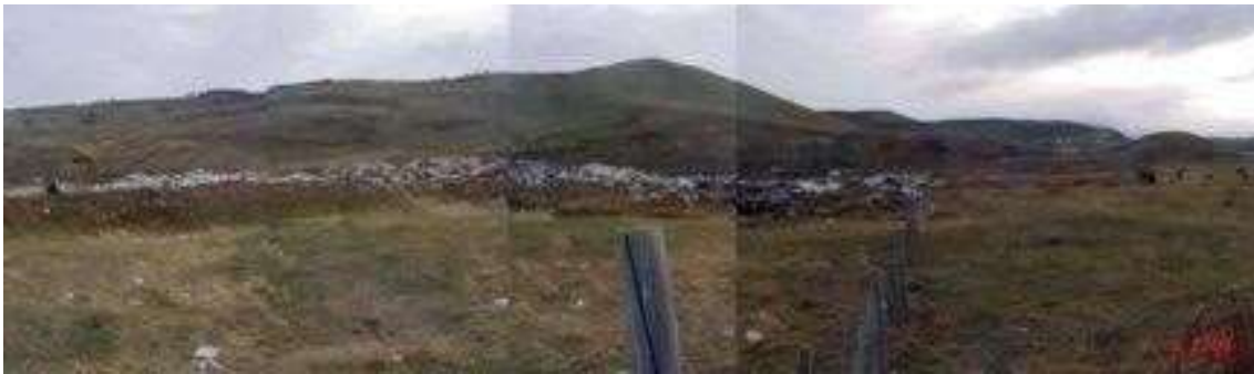
Imagen Nº 137. Vista panorámica del basurero municipal antes del comienzo de las obras
