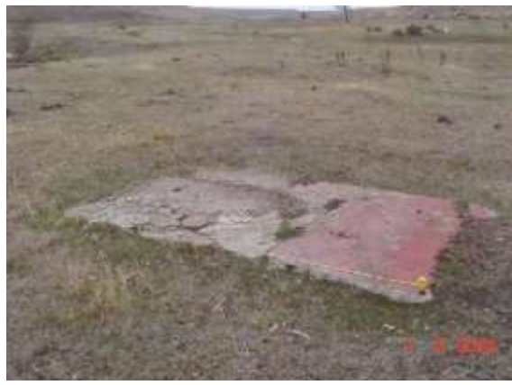
Imagen N° 131. Contrapiso de las dependencias del ferrocarril Fuente: elaboración propia en base a recopilación de antecedentes Serman y Asoc. (2008) y UTN (2011 y 2015).
