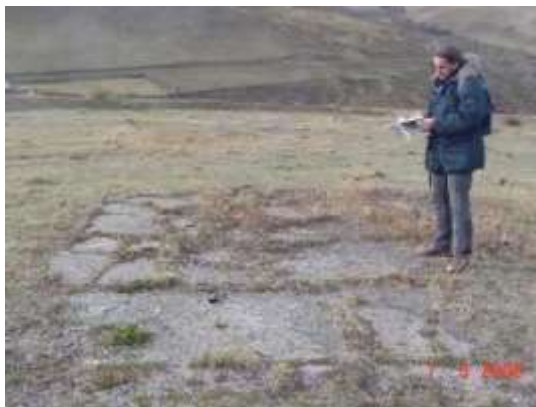
Imagen N° 128. Contrapiso de las dependencias del ferrocarril
