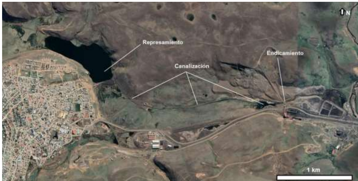
Imagen N° 21. Imagen satelital donde se observa el arroyo San José en la sección modificada por el represamiento, la canalización y el endicamiento hacia el este
