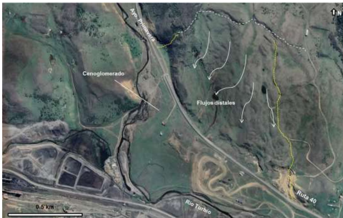
Imagen N° 18. Detalle de imagen satelital donde se observa flujos distales y un depósito de cenoglomerado producto de los mismos ubicado 2 km aguas arriba de la CTRT.
